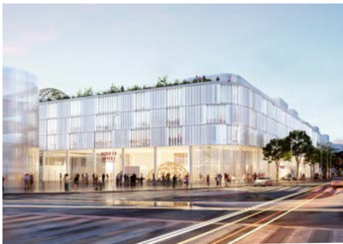
Futur bâtiment de L'École de design Nantes Atlantique en 2022, sur l'île de Nantes
